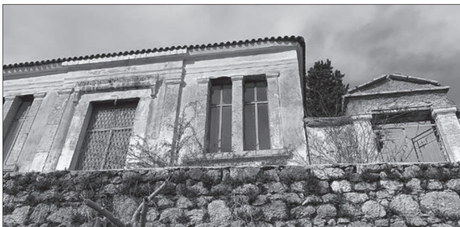
Τό κτίριο του Μονοταξίου Δημοτικού Σχολείου Άγιου Γεωργίου.
